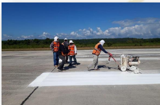
TRABAJOS DE DEMARCACIÓN DE PISTAS EN LOS DISTINTOS AEROPUERTOS Y AERÓDROMOS DEL PAÍS.
