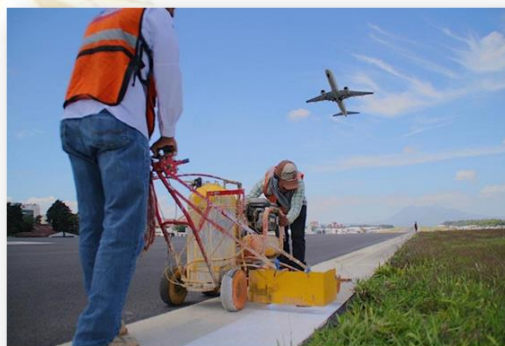
TRABAJOS DE DEMARCACIÓN DE PISTAS EN LOS DISTINTOS AEROPUERTOS Y AERÓDROMOS DEL PAÍS.
